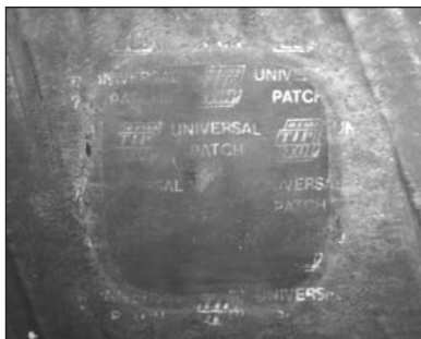
Ryc. 26. – Uniwersalny wkład naprawczy zastosowany na miejscu pierwszego uszkodzenia.
