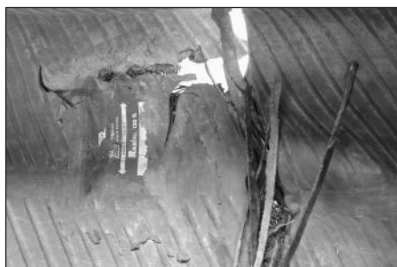
Ryc. 27. – Wkład naprawczy zastosowany na miejscu drugiego uszkodzenia.
