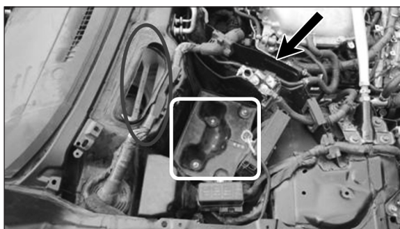
Ryc. 3. Widok wnętrza po prawej stronie komory silnikowej. Kolorem szarym oznaczono wlot kanału wentylacyjnego, kolorem białym oznaczono miejsce montażu akumulatora, czarna strzałka wskazuje ścianę oddzielającą wnękę od przedziału silnikowego.
