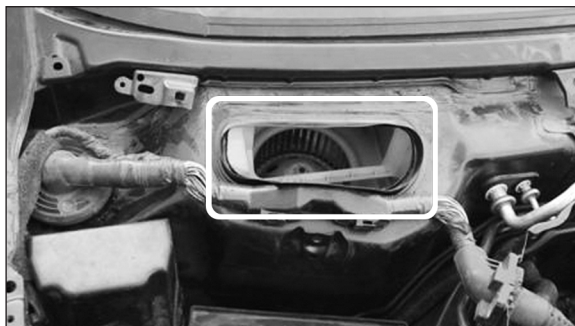
Ryc. 2. Widok kanału wlotowego powietrza od strony komory silnikowej. Wewnątrz kanału widoczny jest wentylator wymuszający obieg powietrza wewnątrz kabiny.
